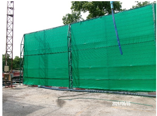
รูปที่ 3-27 สแลนกันฝุ่น บริเวณริมรั้วภายในพื้นที่โครงการ
