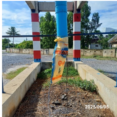
รูปที่ 3-12 ถังกระสอบขนาดใหญ่รองรับเศษวัตถุที่ตกหล่นจากสายพานลำเลียง
