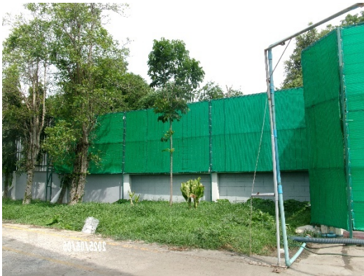
รูปที่ 3-27 สแลนกันฝุ่น บริเวณริมรั้วภายในพื้นที่โครงการ
