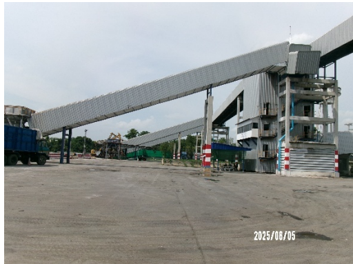
รูปที่ 3-9 ติดตั้งอุปกรณ์ปิดได้สายพานลำเลียงที่ 2 และ 3
