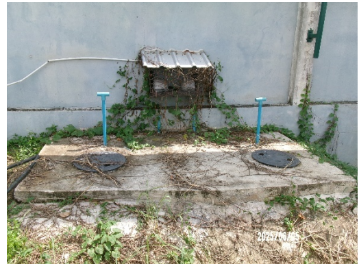
รูปที่ 3-14 ระบบบำบัดน้ำเสียสำเร็จรูปชนิดเติมอากาศ แบบ Aerobic Fixed Film
