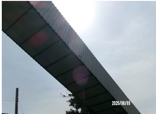
รูปที่ 3-9 ติดตั้งอุปกรณ์ปิดได้สายพานลำเลียงที่ 2 และ 3
